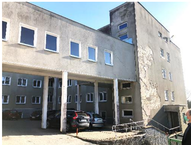
3 pav. Remontuojama pastato dalis iš pietų pusės (8D4p)
