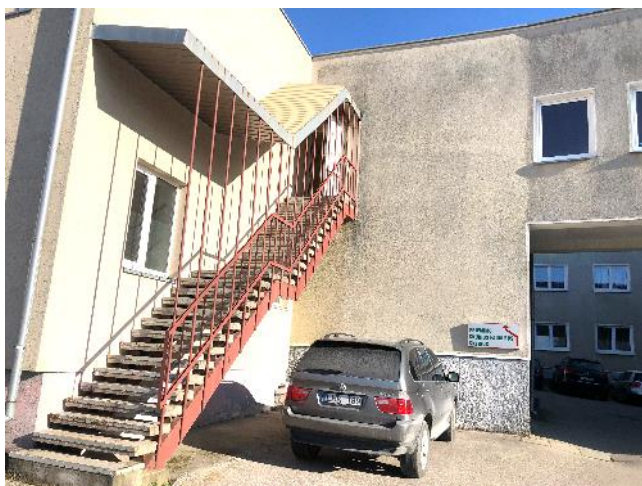
2 pav. Remontuojama pastato dalis iš pietų pusės (5D4p)
